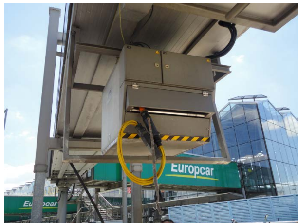
Bild 5: Kabel-Coiler unterhalb der Fluggastbrücke
