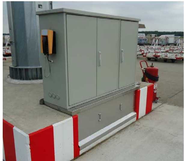
Bild 5: Mastverteiler
